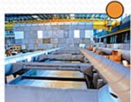
Vakuumkärl i titan till yttre toroid. Supraleadarna ska läggas i och en övre halva svetsas på.
