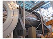
Kryogeniska kärlet som innehåller inre solenoiden
